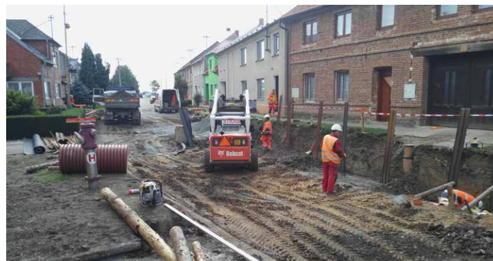
Oprava dešťové kanalizace v první etapě stavby
