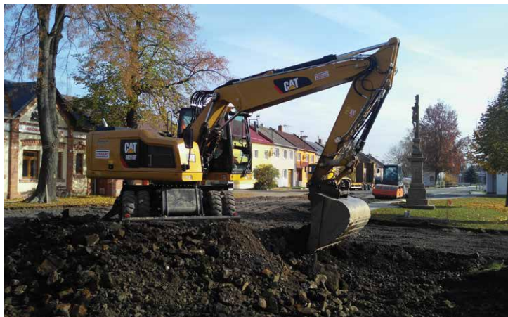
Výkopové práce před hasičskou zbrojnicí
