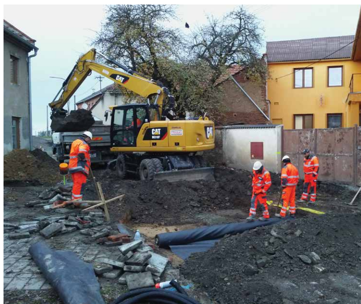
Stavební práce v místě zúžení silnice
