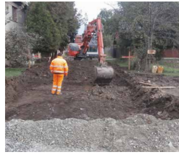
Výkopové práce na komunikaci
