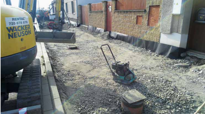
Výstavba vjezdu, chodníku a parkovacího stání
