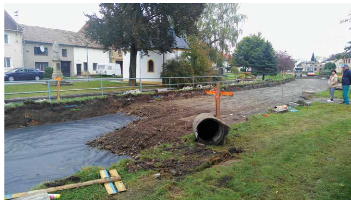
Průběh stavby v centru obce
