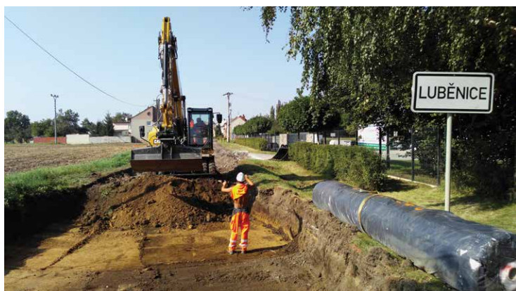
Zahájení stavby směrem na Lutín
