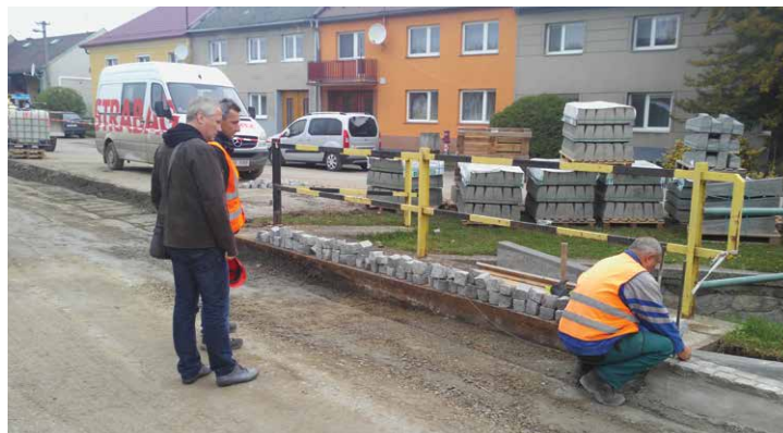
Kontrolní den na stavbě
