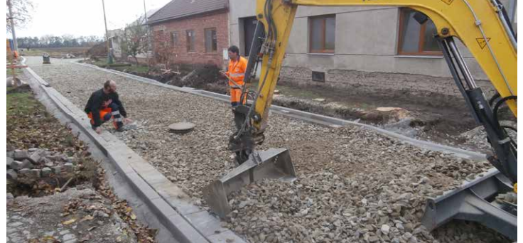
Nová konstrukce silnice
