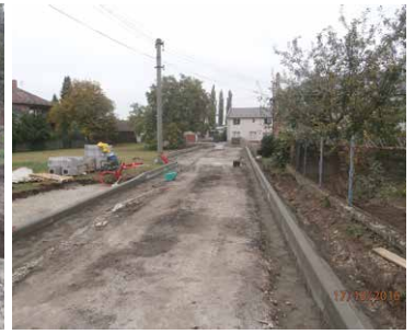
Pokládka obrubníku a přídlažby
